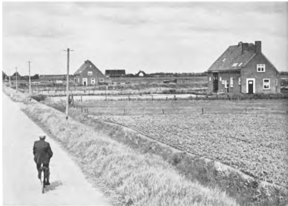
Modernisering betekende ook verplaatsing van boerderijen naar het land en in de buurt van een verharde weg.
