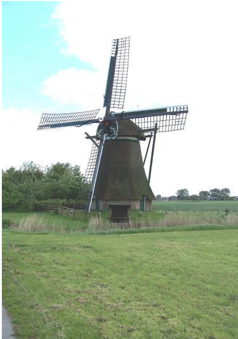
De Schalsummolen bij Franeker. Een achtkantige rietgedekte bovenkruier met een vlucht van 20,20 meter uit 1801. Dergelijke grote molens werden pas aan het eind van onze periode gebouwd in Friesland en dienden om grotere gebieden te bemalen, in dit geval de Schalsumpolder.
