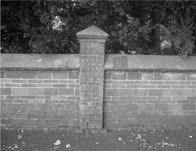
Abb.17 Friedhofsmauer (1,2 m hoch) in östlichen Teil (parallel zur Blinke). Auffällig sind die unterschiedlichen Formate der Steine und die pyramidenförmig zulaufenden „Türmchen“ (1,6 m hoch) (Foto: Autors)
