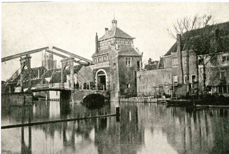
Spuiport in Dordrecht (source: Blink, Tussen Eems en Schelde , 1903)
