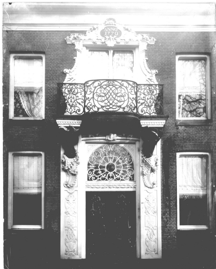
Afb. 23 Het in 1770 aangelegde Hof van Iddekinge of Boumanshof stond tot 1913, toen het plaats moest maken voor de W.A. Scholtenstraat aan de Turfsingel. Eigenaar van dit landhuis in de stad was Berend Iddekinge, broer van de machtigste man in Groningen, luitenant stadhouder Anthony Adriaan van Iddekinge (1711-1789), en gehuwd met Johanna Maria, dochter van de schatrijke Jan Albert Sichterman (Gron. Arch. 1785-13838).
