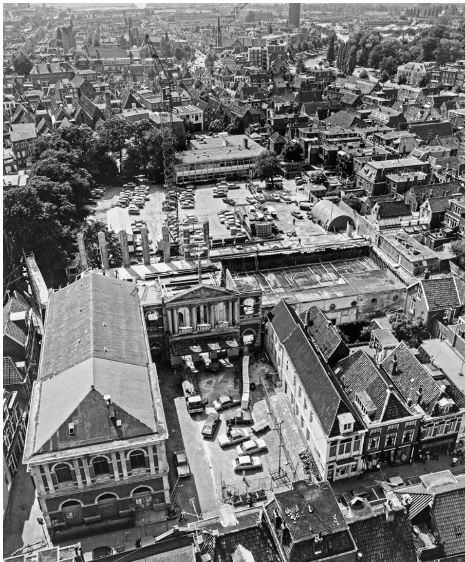
108 Bouwwerkzaamheden voor De Harmonie. Collectie Universiteitsmuseum Groningen.
