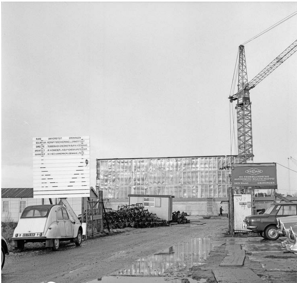
23 Het Kernfysisch Versneller Instituut in Paddepoel in aanbouw, ca. 1965. RHC Groninger Archieven.
