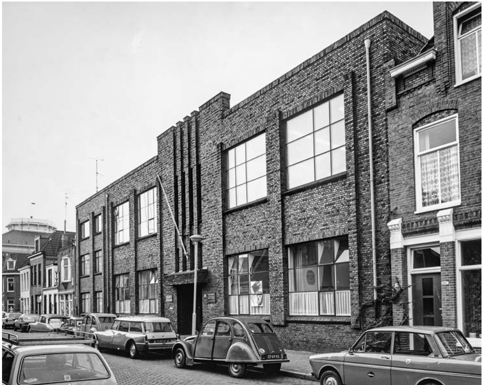
76 Het voormalige Menco-gebouw in de Nieuwe Kijk in 't Jatstraat, tehuis van het Rekencentrum, het Museum Gerardus van der Leeuw, en de Faculteit der Godgeleerdheid en Godsdienstwetenschap. Collectie Universiteitsmuseum Groningen.
