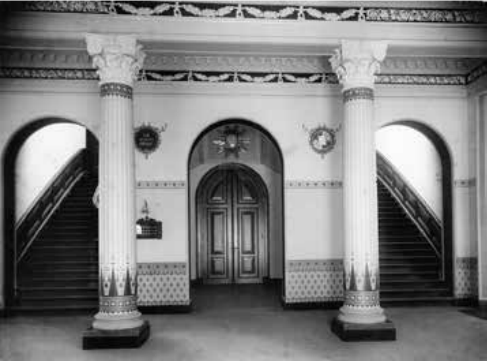
Afb. 19 De vestibule van het oude Academiegebouw. Achter de deur lag de aula. Collectie Universiteitsmuseum Groningen.
