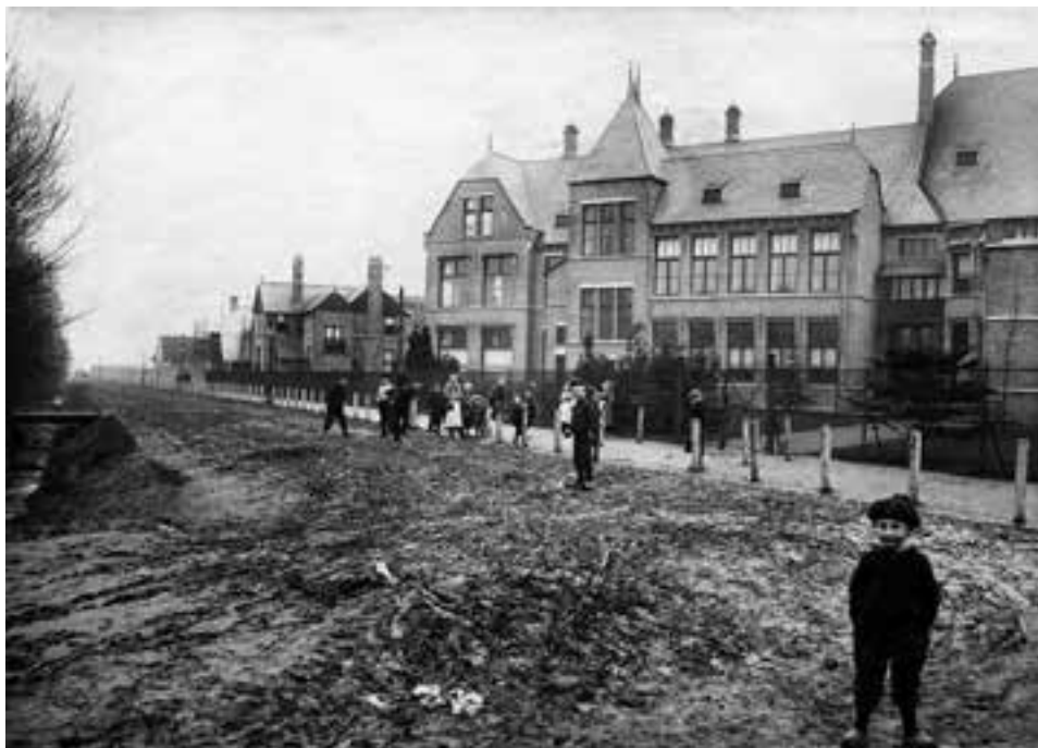
Afb. 28 Het Pathologisch-Anatomisch Laboratorium aan de Oostersingel, ca. 1907. De Oostersingel was toen nog niet veel meer dan een modderige weg. Verderop wordt gebouwd aan het aanpalende Anatomisch-Embryologische Laboratorium. Collectie Universiteitsmuseum Groningen.
