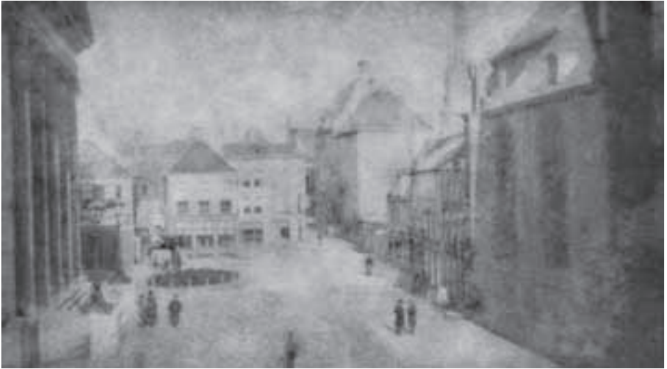
Afb. 94 Het Academieplein (Broerstraat) te Groningen, 1885-1890. Maker van de foto is onbekend. Collectie Universiteitsmuseum Groningen. Links het nieuwe Academiegebouw.
